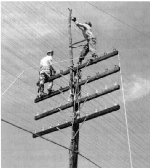
Comportamiento inadecuado con un elevado riesgo de sufrir un accidente. Motivo del origen de una no conformidad.
